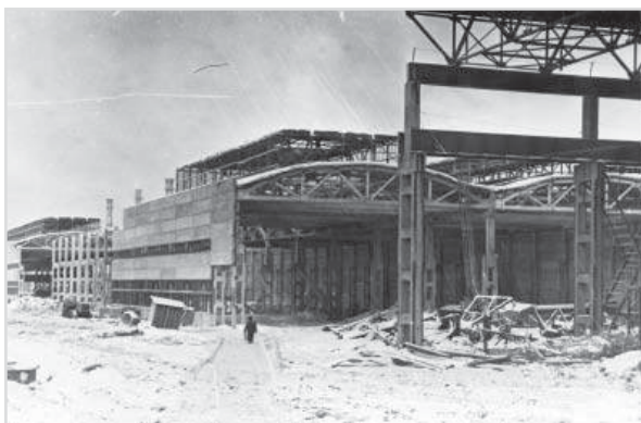
Строительство корпуса инструментального производства
