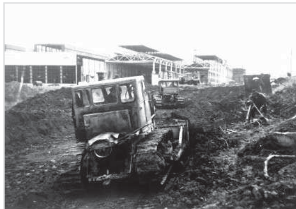
Строительство завода. 1960-е годы
