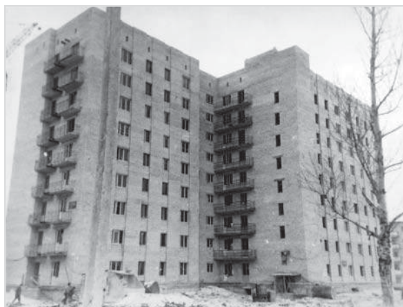
Строительство первого девятиэтажного дома (№13)
