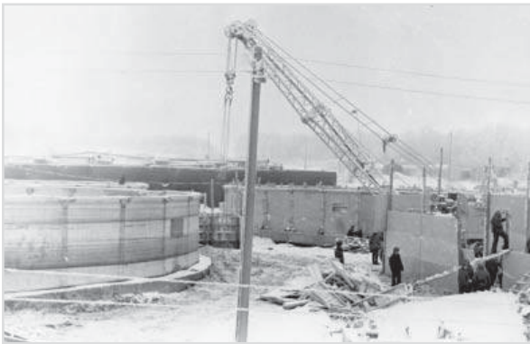
Монтаж мазутохранилища для паросилового цеха
