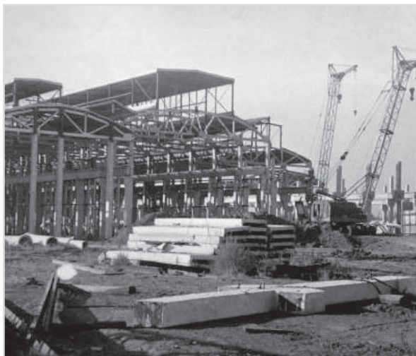
Возведение заводских корпусов
