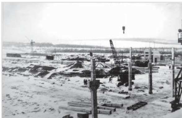
Строительные работы продолжались даже зимой
