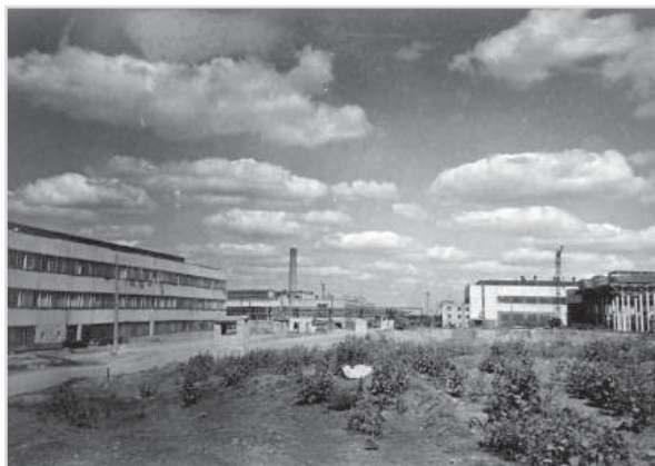
Место для закладки будущего инженерно-бытового корпуса механосборочного производства
