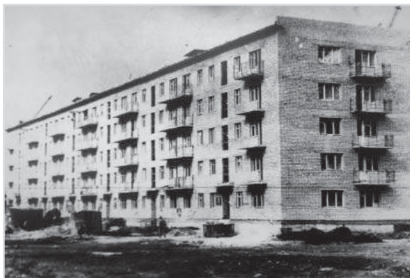
Завершается строительство дома в микрорайоне №1
