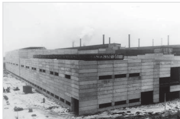
Строительство корпуса механосборочного производства идет к завершению
