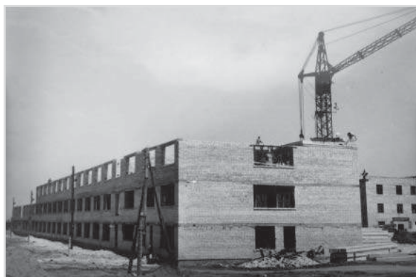
Бытовые помещения корпуса заготовительных вспомогательных цехов №1 (административный корпус цеха горячих штампов)
