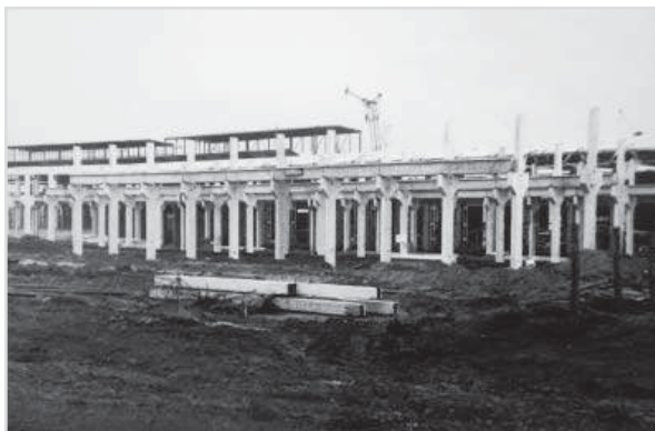
Начало строительства корпуса механосборочного производства
