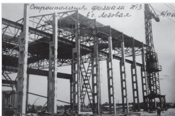
Корпус будущего цеха
