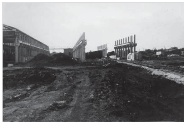
Строящиеся производственные и бытовые корпуса завода
