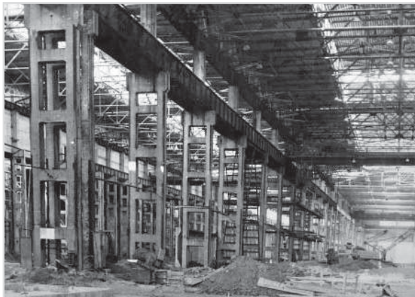
Строительство блока цехов рамного производства
