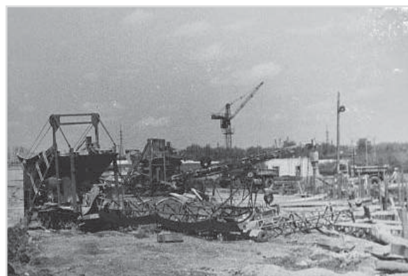
Подготовка техники для начала строительных работ
