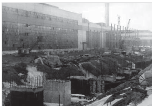
Закладка фундамента под строительство 4-й очереди корпуса КЦ-2
