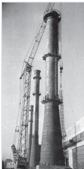
Монтаж вытяжных труб КЦ-2
