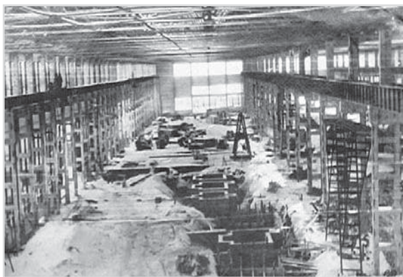
В кузнечном цехе продолжаются строительные работы
