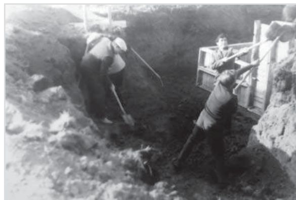
Земляные работы по закладке фундамента выполняет бригада Я.Т. Шачанина
